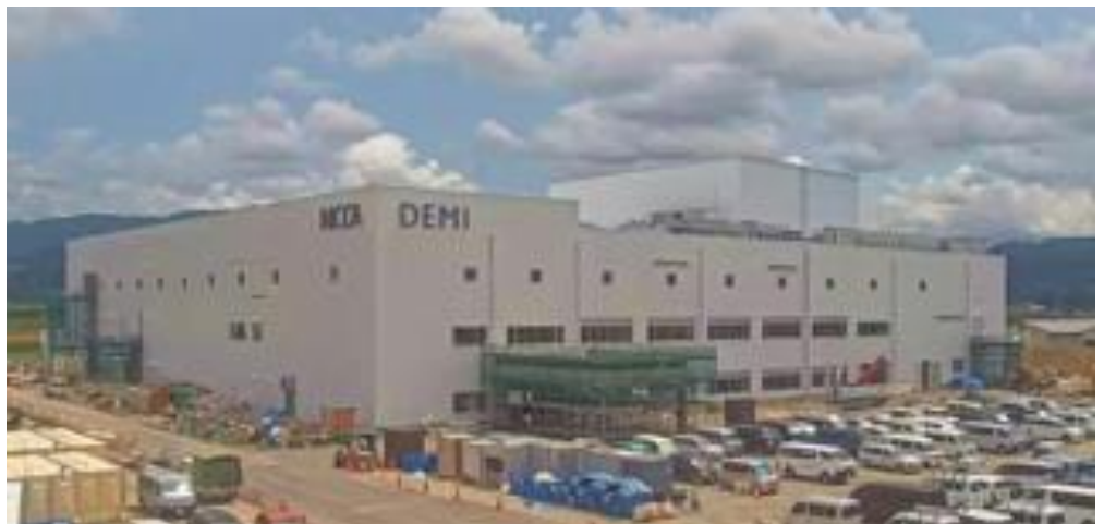
図表 50. 福井スマートファクトリー外観（建設中、2026 年 7 月 29 日現在）
