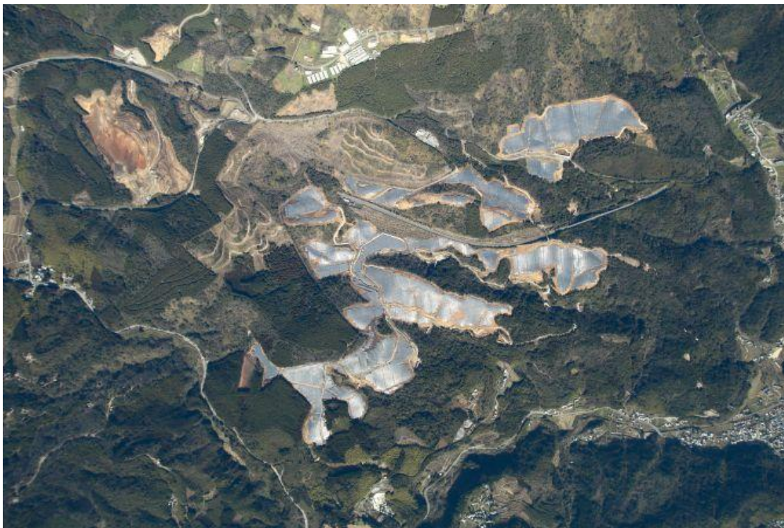
図表 13. CS 日出町第二発電所 (大分県) (54MW)
